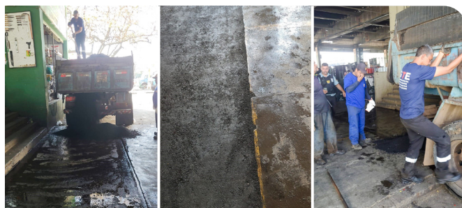
Correção do asfalto no Setor D, que havia cedido.
