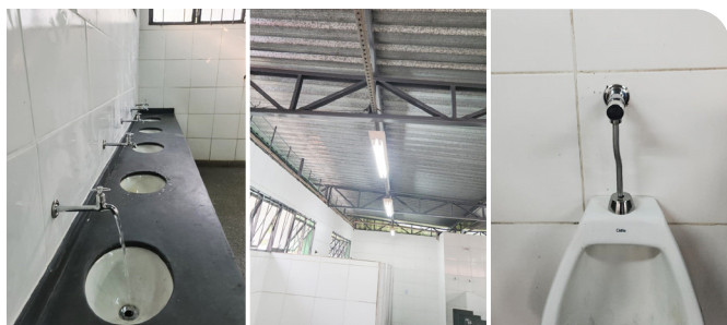
Reforma do banheiro no Pavilhão 5 concluída, com liberação para o público.
