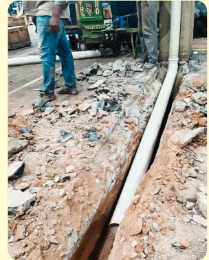
Obras de drenagem nos setores A, B e C.
