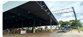
Foram iniciadas as obras de restauração do telhado do MLP. A antiga estrutura, danificada por uma ventania, foi removida para instalação da nova estrutura.
